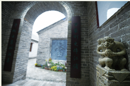
修缮后的李家当铺院。
